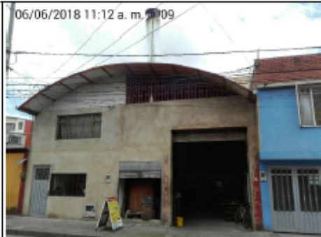
FOTOGRAFIA 1. FACHADA DE PREDIO Y DUCTO DE LA PARRILLA TROMPO
